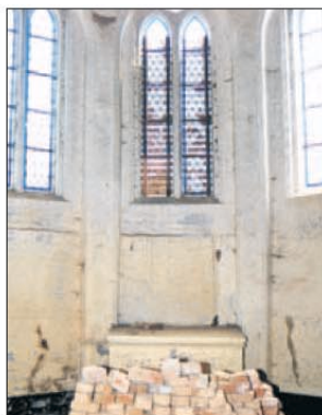
Die Kapelle St. Georg in der Sundischen Straße während des Umbaus im Jahre 1999.
